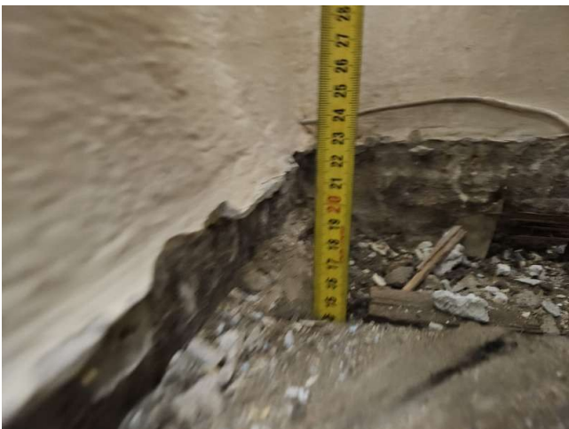
Konstrukcja stropu nad parterem
